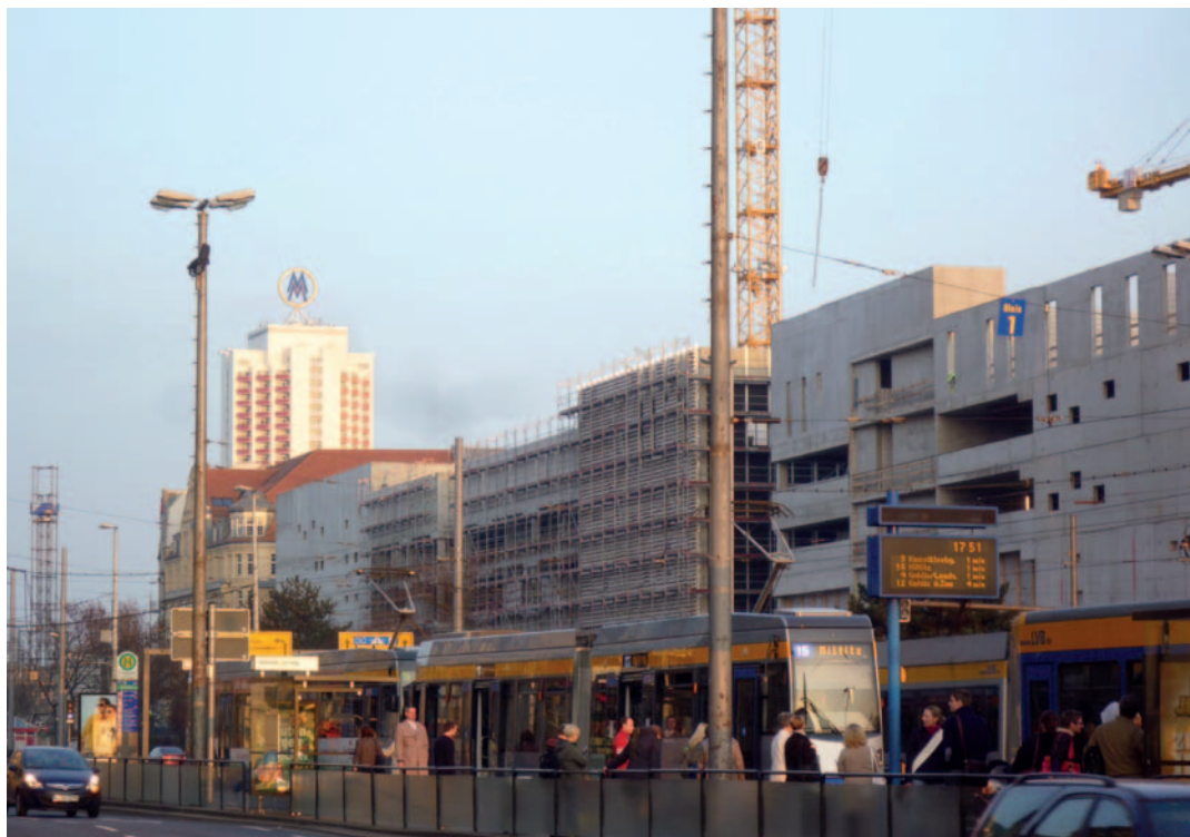
Baustelle Höfe am Brühl
