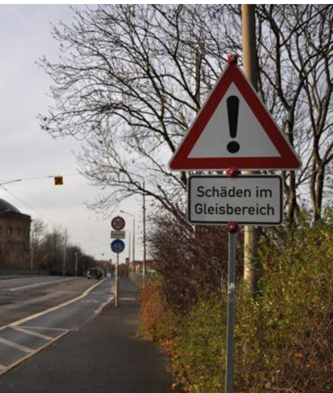
Sanierung und Erweiterung statt Rückbau! Die Gleisanlagen der Schlachthofbrücke bleiben erhalten.
