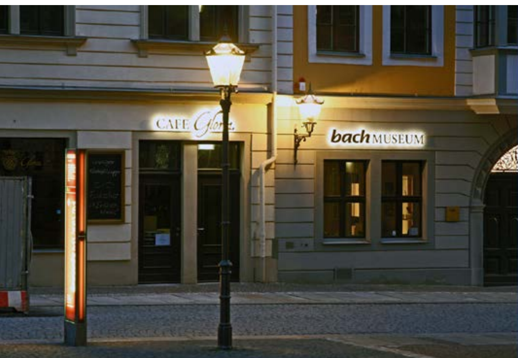
360 Schinkel-Leuchten wurden im Stadtzentrum auf LED umgestellt
